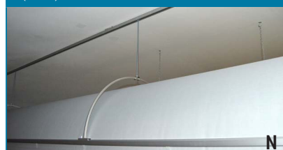
用于弧形悬吊装置的型材 ( N )
